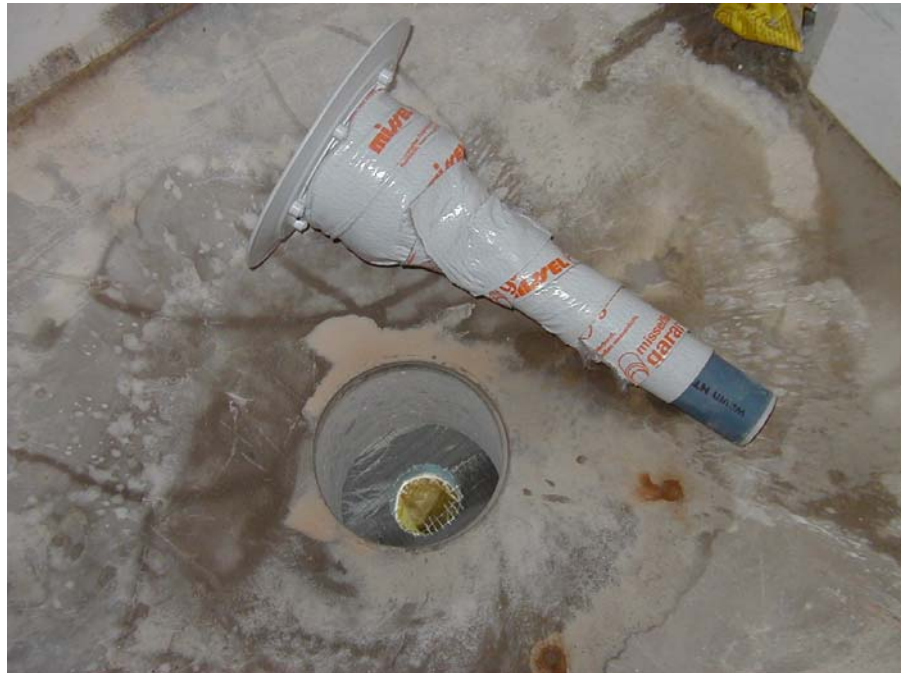
Anlage 1.3 Wedi Fundo mit nonstep plan + Estrich, Ablauf senkrecht
