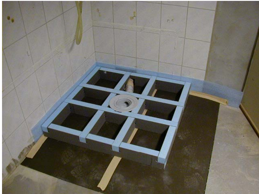
Anlage 1.2 Easy-Set mit nonstep plan, Ablauf waagrecht
